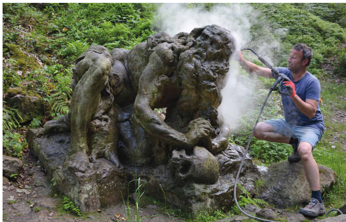
Obr. 4 K zahubení vegetace a jejímu odstranění z hloubek modelace je vhodné užití vodní páry, která nezatěžuje materiál nadměrným množstvím vody. [PZ]
