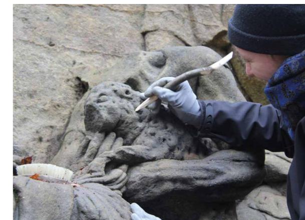
Obr. 3 Maximálně šetrné odstranění vyšších rostlin bylo zajištěno použitím měkkých kartáčů a dřevěných špachtlí, pro práci v modelačních hloubkách upravených do špičky. [PZ]
