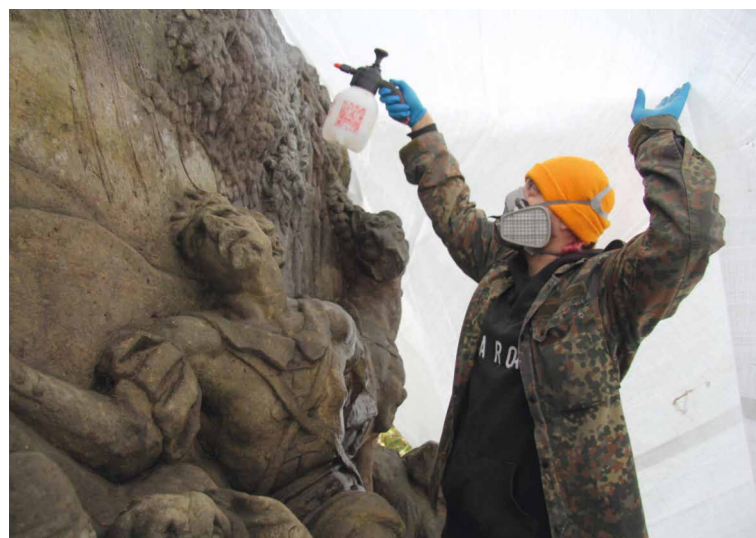
Obr. 4 K zahubení vegetace a jejímu odstranění z hloubek modelace je vhodné užití vodní páry, která nezatěžuje materiál nadměrným množstvím vody. [PZ]
