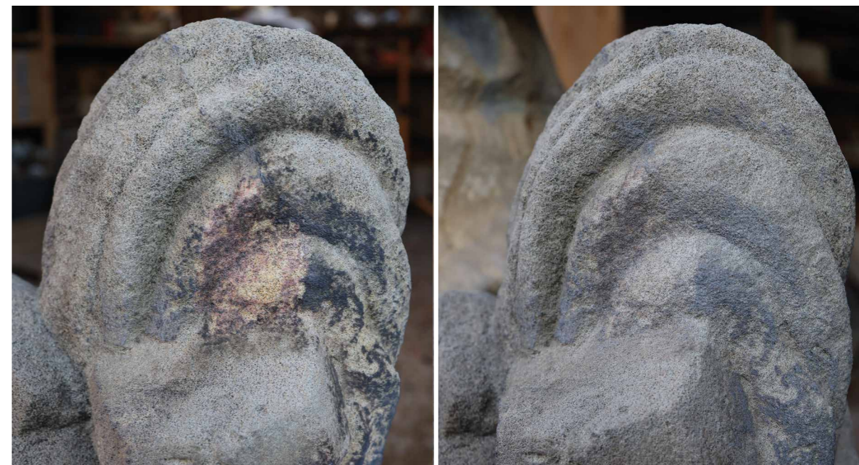
Obr. 2 Drapérie poškozená laserem při neodborném zásahu. Povrch je odprýskaný a pískovec zbarvený do červena (levá část snímku). Stejně místo po dočištění pulzním laserem. Tmavé filmy jsou odstraněné a červené zbarvení se podařilo do značné míry redukovat (pravá část snímku). Potštejn, socha sv. Venancia. [PG, 2025]
