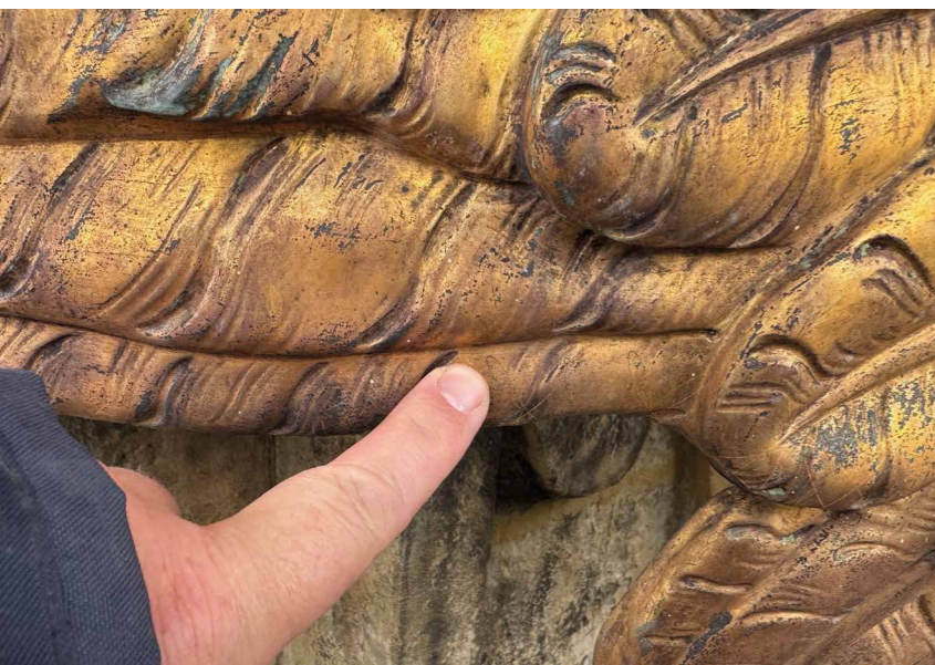
Obr. 7 Pohled na zlacené křídlo jednoho z andělů zasažené laserovým paprskem (vypálené linky) při neopatrné manipulaci. Olomouc, Čestný sloup Nejsvětější Trojice, sousoší Nanebevzetí Panny Marie. [PG, 2025]
