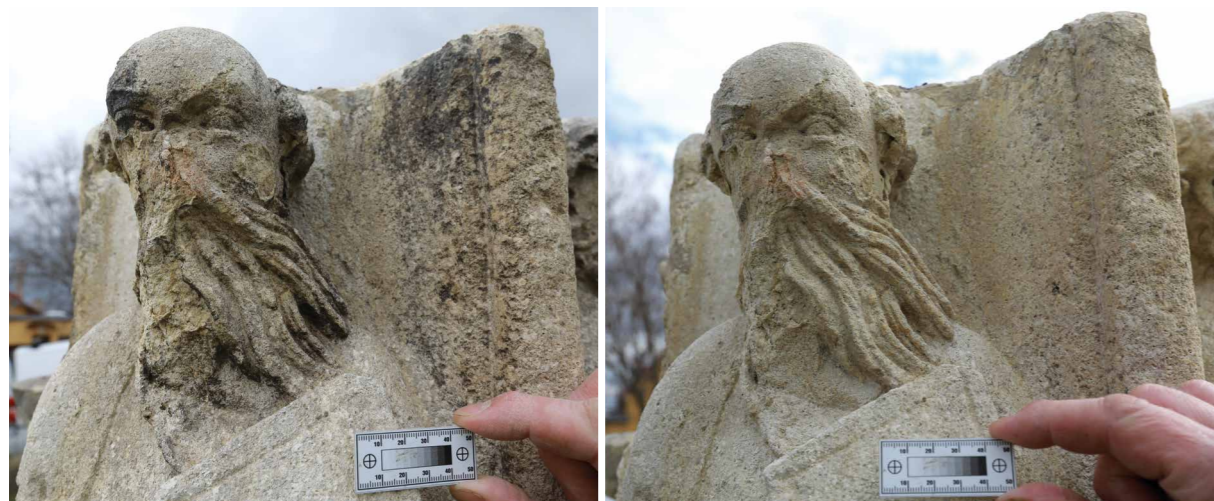
Obr. 3 Ukázka čištění vápence pulzním laserem před (levá část snímku) a po zásahu (pravá část snímku). Spolupráce s Josefem Červinkou. Sedlešovice, Boží muka z roku 1525. [PG, 2025]
