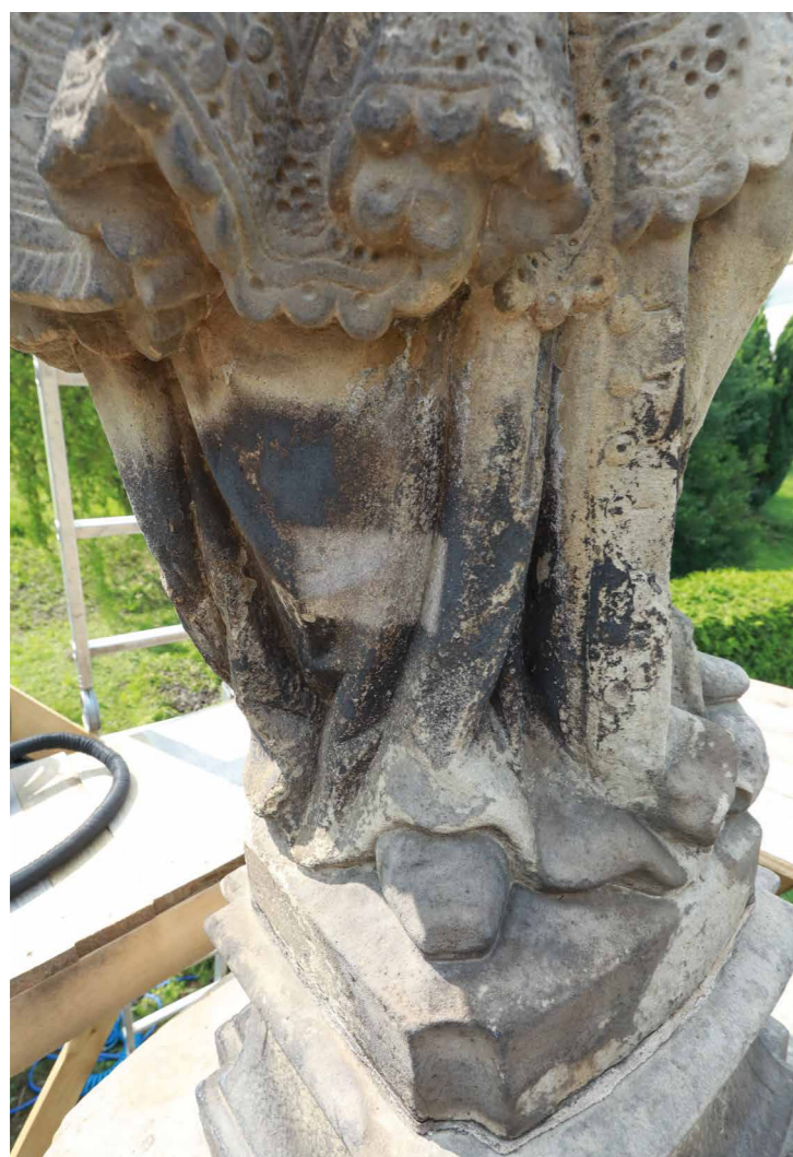
Obr. 9 Zkouška čištění blíže nespecifikovaných ložisek tmavých skvrn na povrchu pískovce. Fragменты povrchových úprav zůstávají bez poškození. Chyjice, socha sv. Jana Nepomuckého. [PG, 2025]
