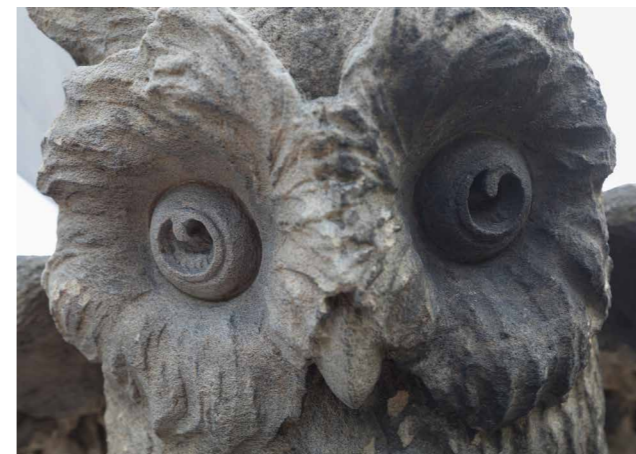
Obr. 6 Ukázka zvolené míry čištění pískovcové sochařské výzdoby prováděné pulzním laserem. Hořice, hřbitovní portál, soška sovy na jedné z trofejí. [PG, 2025]
