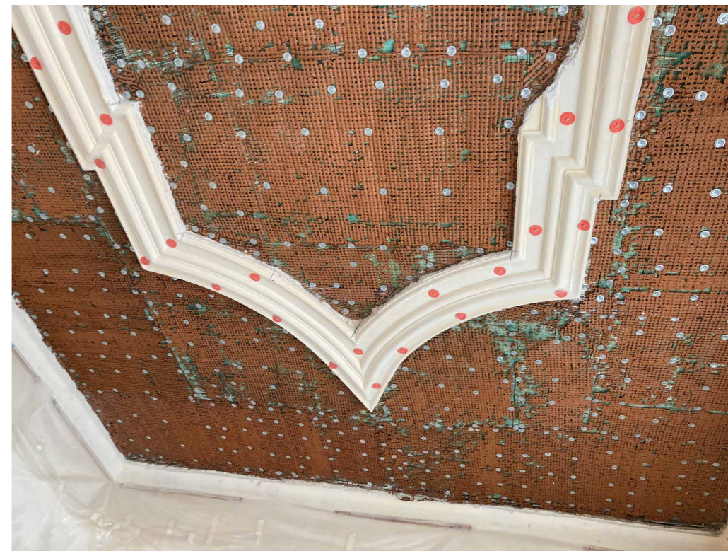
Obr. 6 Zámek Rychnov nad Kněžnou, objekt sala terreny. Strop po instalaci nového rabicového pletiva, před nahozením jádrové omítky. [PL, 2022]
