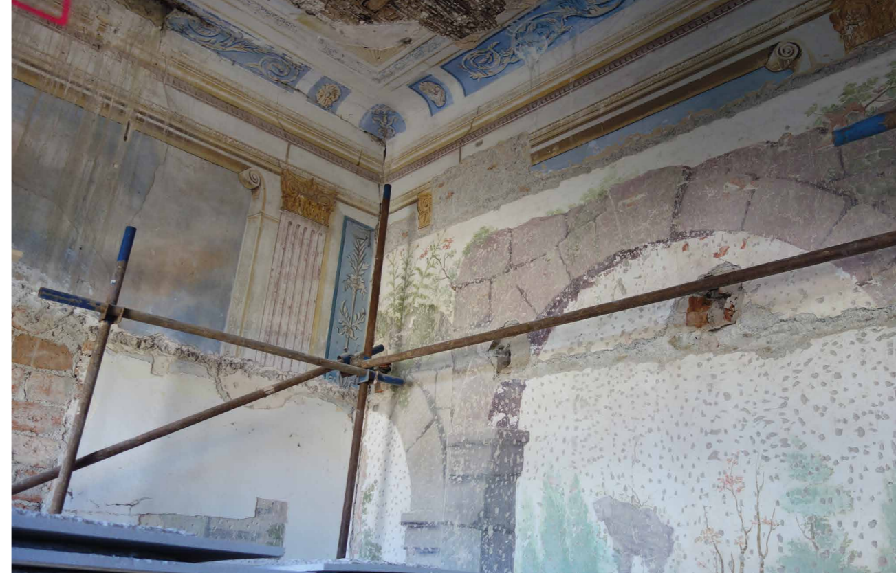
Obr. 4 Pohled na stěny v průběhu restaurátorských odkryvů na rokokovou výmalbu odkrývající motivy obloukové architektury s průhledy do krajiny. [TŠ, 2018]
