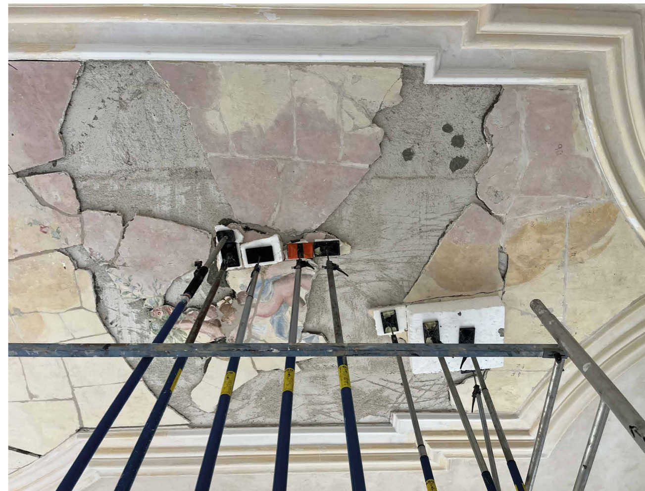
Obr. 8 Zámek Rychnov nad Kněžnou, objekt sala terreny. Strop při druhém osazování transferovaných dílů, stav v průběhu restaurátorských prací. [LH, 2022]
