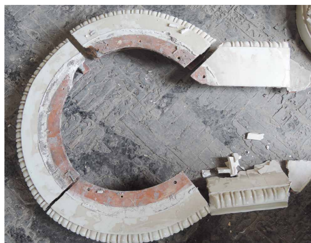
Obr. 10 Rozpad sádrové kopie kachle střední římsy umístěné nad topným tělesem. [SRČ]
