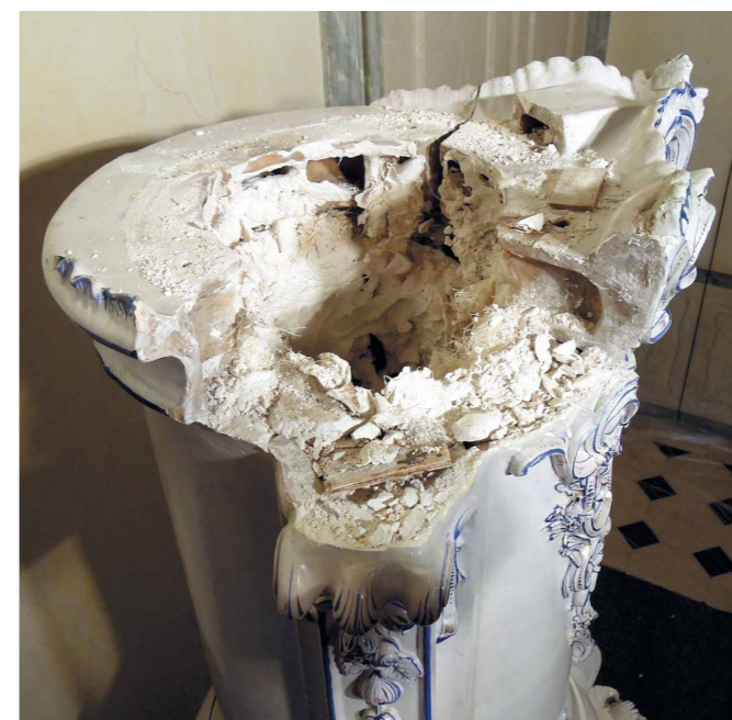
Obr. 3 Demontáž kachlových kamen postavených s použitím sádry s kokosovými vlákny. [SRČ]
