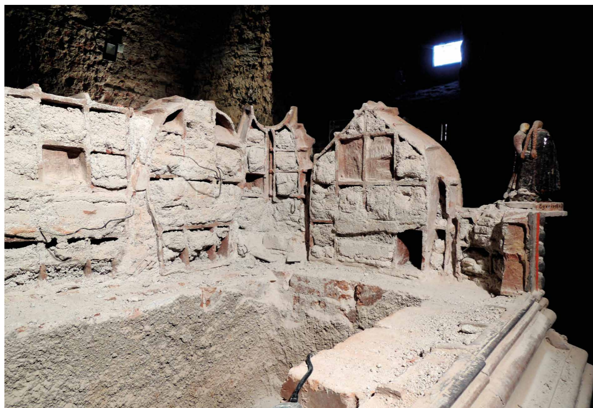
Obr. 8 Postupné odřezávání a odsekávání cementových výplní při demontáži chebských národopisných kamen. [SRČ]
