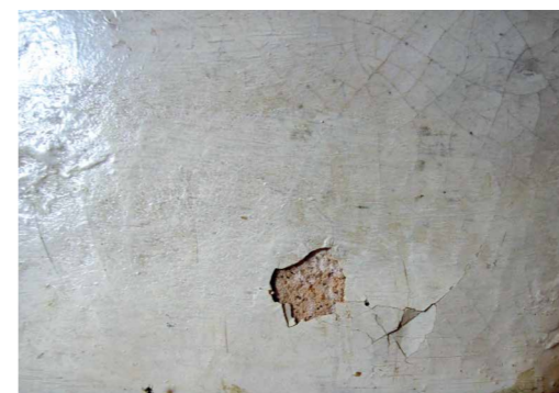
Obr. 6 Uvolnění glazury na kachli opraveném sádrou a zatřeném barvou. [SRČ]
