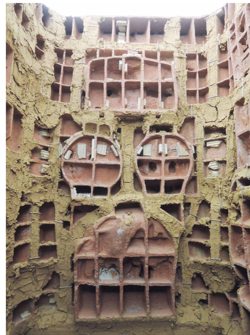
Obr. 9 Současná rekonstrukce týchž kamen s použitím tradičních výplní kamnářskou hlínou. [SRČ]
