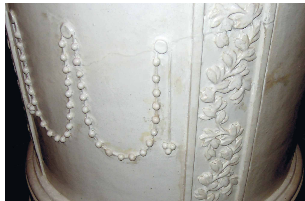
Obr. 7 Barevně změněné retuše provedené syntetickou olejovou barvou i přes okolní glazuru. [SRČ]
