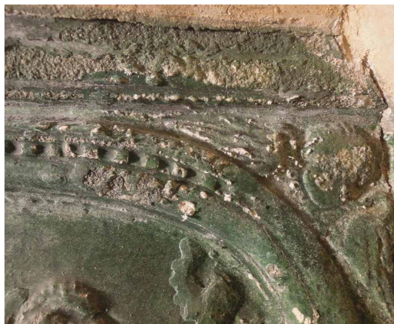
Obr. 5 Krystalizace solí a rozpad střepu a glazury pod nátěrem zelené barvy. Detail vpravo po zvětšení USB mikroskopem. [SRČ]
