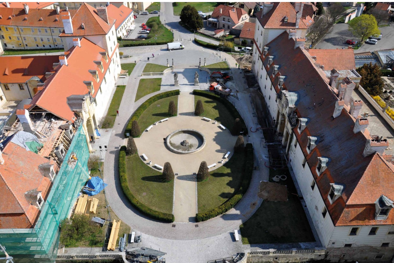
Zámek Valtice, Čestné nádvoří – stav okolních objektů před obnovou, průběh oprav střechy nad konírnou, 2009. [MP]
