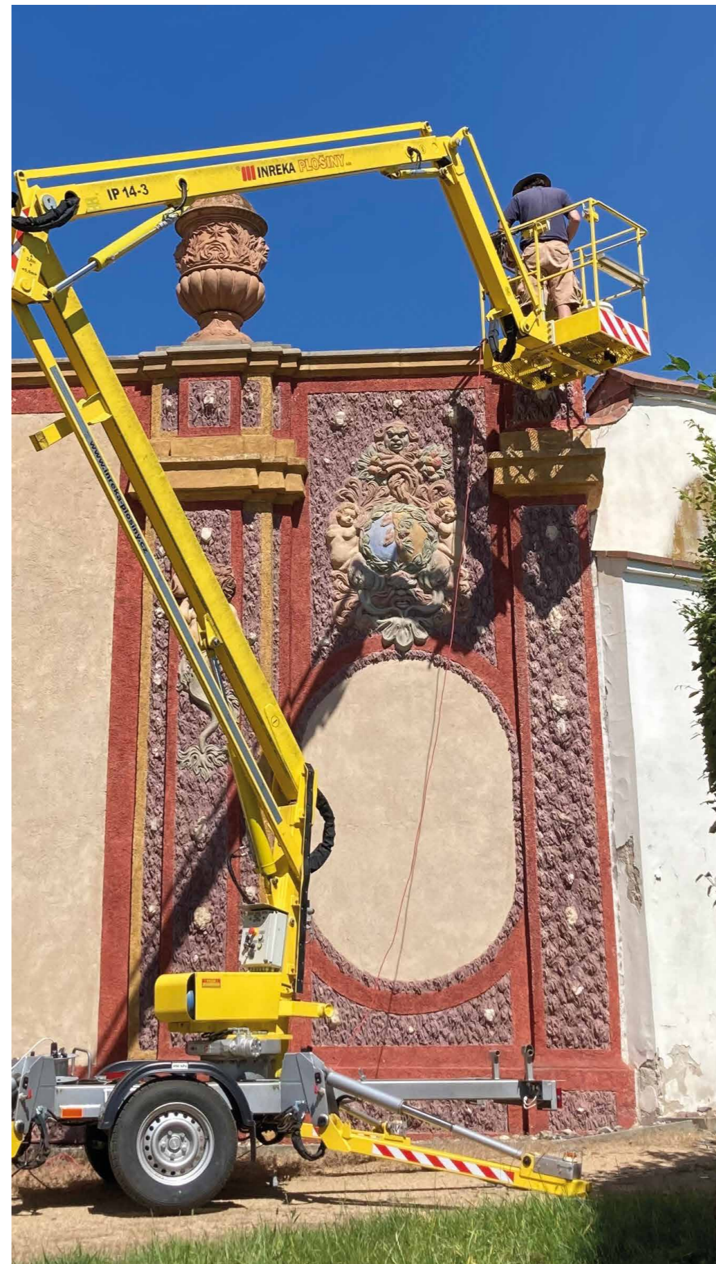
Obr. 4 Monitoring stavu váz na ohradní zdi, rok 2025. [BV]
