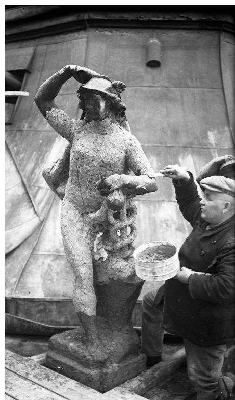
Fig. 2 Leaching of colour layers from the sculpture Hermes at Kronentor attic. [H. Ermisch, Landesamt für Denkmalpflege Sachsen, 1925]
