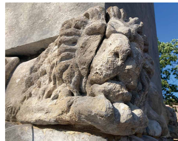
Obr. 7 Detail hlavy lva po odstranění tmelů a zpevnění. V této fázi je připraven na injekci hlubokých dutin a následné tmelení. [PM]
