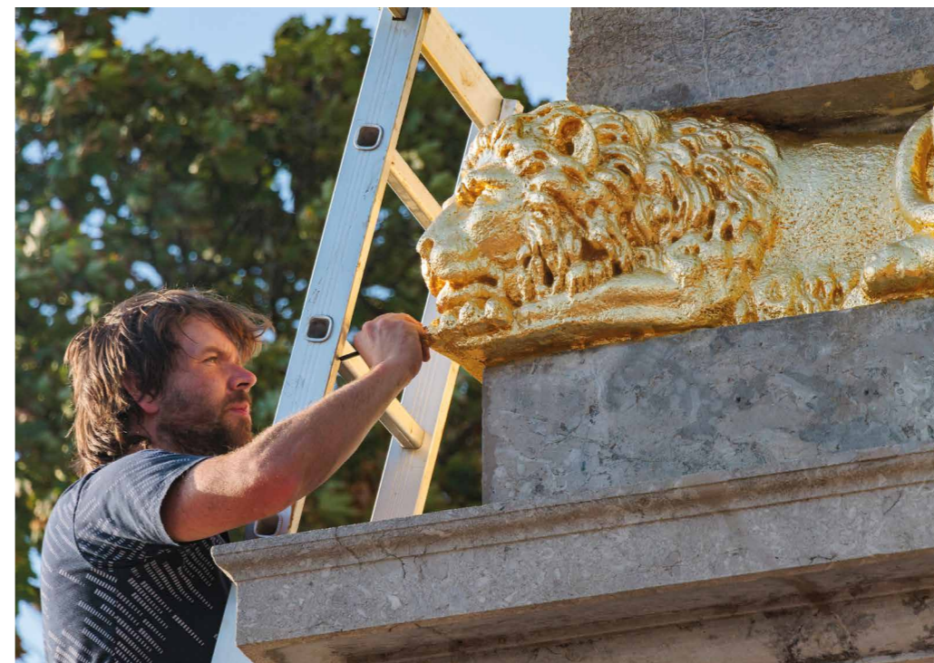
Obr. 9 Po třech vrstvách nátěru italského mixtionu plněného pigmenty následovala poslední vrstva, na kterou bylo aplikováno plátkové zlato. [VK]
