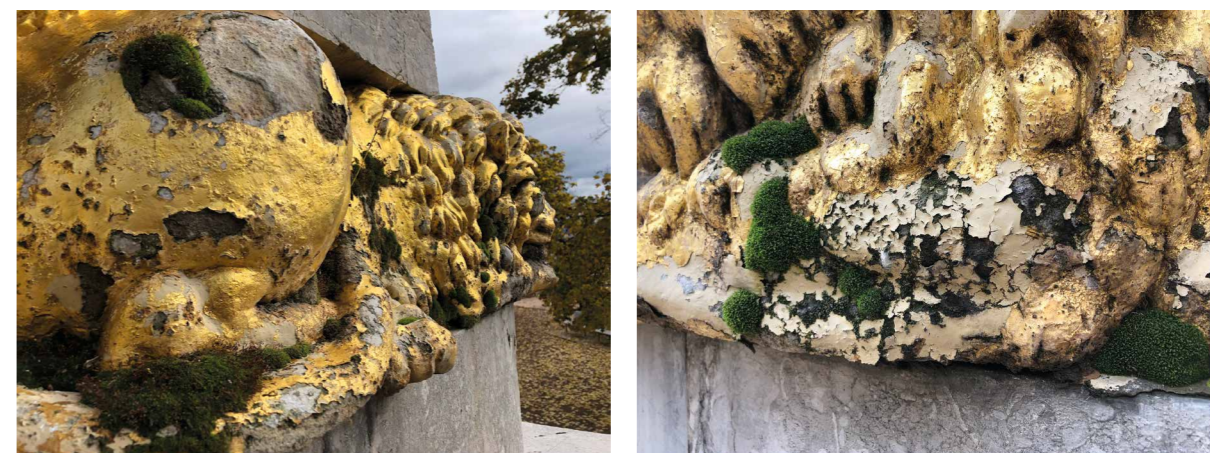
Obr. 3–4 Povrch lvů před restaurováním vykazoval odlučování nátěru včetně hluboce degradované horniny. Nátěry se šupinatě odlučovaly i mezi jednotlivými vrstvami. [PM]
