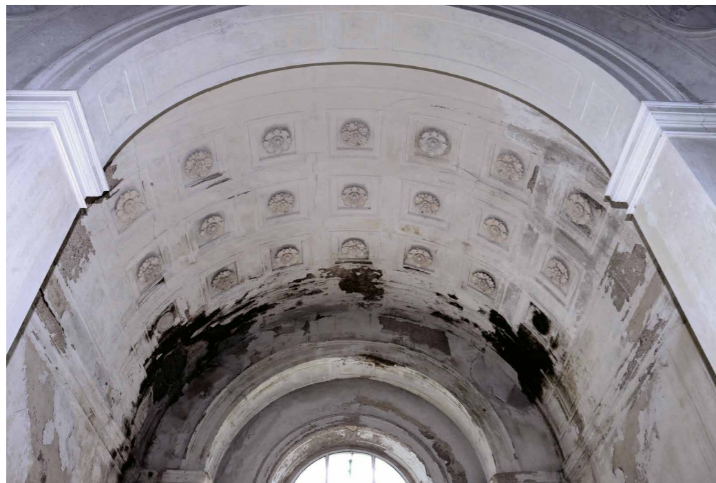
Obr. 4 Klenba boční lodě mauzolea s kasetovou výzdobou stropu vycházející z Palladioových recepcí antických předloh. [DCH]
