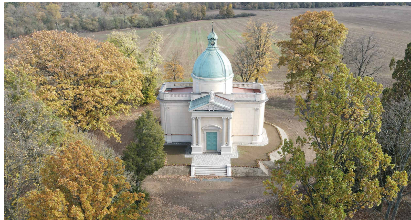
Obr. 2 Letecký pohled na mauzoleum Pallavicini. [LK]
